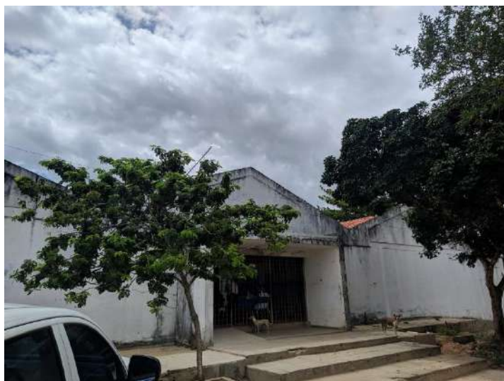
Figura 1: Fachada da Escola Municipal Dr. José Roberto Monteiro
