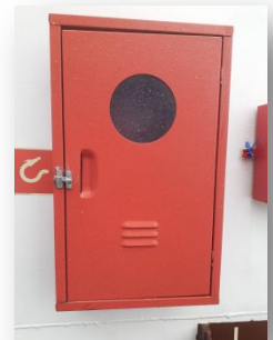
Instalação de caixas de incêndio
