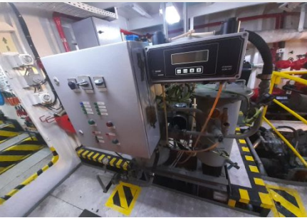
- Conserto de separador de água e óleo
