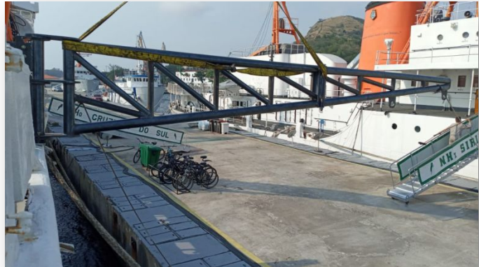
Confecção de braço de arrasto de equipamentos científicos
