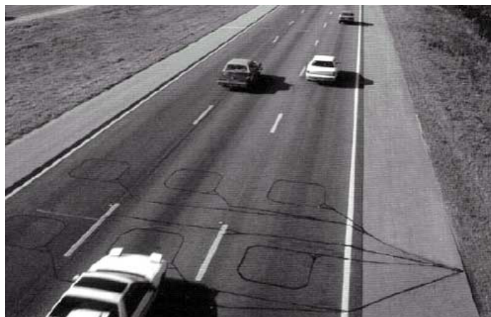
Figura 2.2. Laços indutivos retangulares instalados em rodovia. As duas unidades instaladas em cada faixa de rolamento possibilitam a medição de velocidade e contagem de veículos. Uma única unidade possibilitaria apenas contagem. Fonte: (REIJMERS, 2006)
