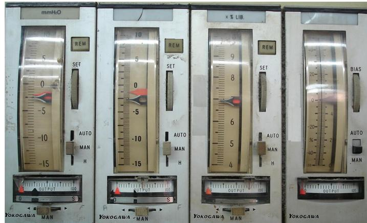
Figura 1.6: Ilustração dos controladores de processo no painel.
