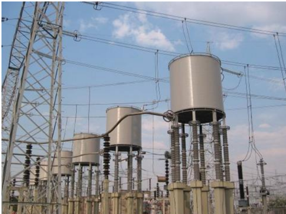
Figura 3.3 – Reator Linear Série com núcleo de ar aplicado em alta-tensão.
