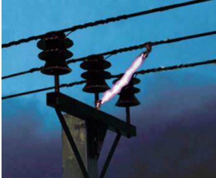
Figura 24 – Fenômeno de flashover em uma linha de distribuição
