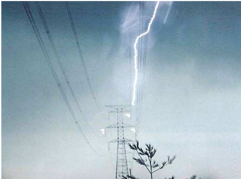
Figura 25 – Fenômeno de backflashover numa linha de transmissão.
