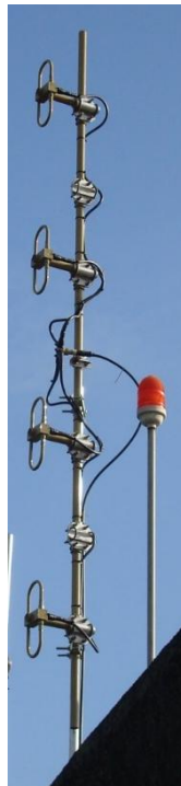
Fig. 31 – Um arranjo de antenas colinear com quatro dipolos dobrados.
