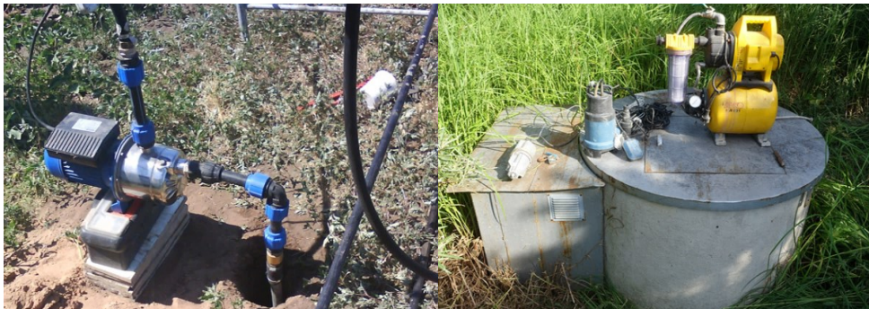
(e) Captação em poço artesiano (f) Captação em poço profundo
