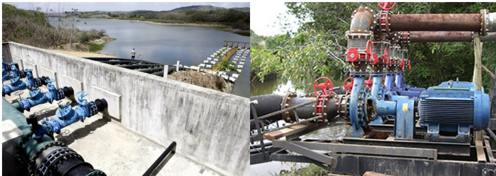
(e) Captação em poço artesiano (f) Captação em poço profundo
