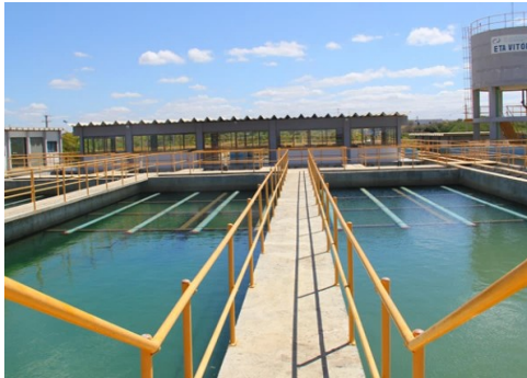
(c) Coagulação, decantação e filtração
