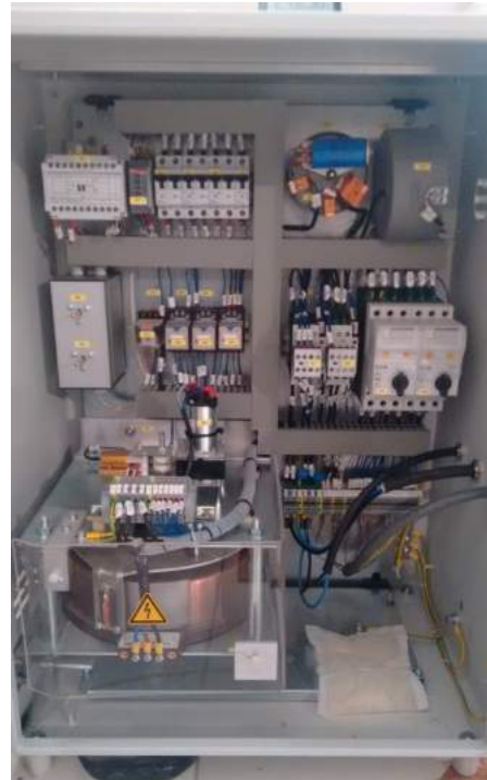
Figura 59 – Cubículo de comutação
