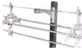
Figura 8 – Braço tipo “L” em condições de tangência .
