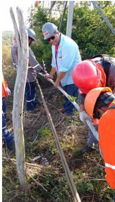
Figura 73 – Enxerto de cabo condutor após troca de estrutura
