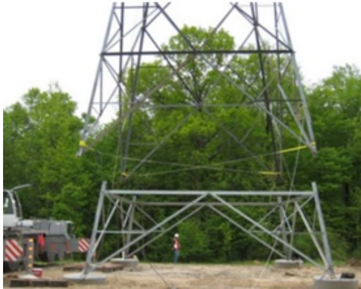
Figura 34 – Colocação da estrutura relocada em novo posicionamento em novos pés
