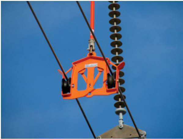
Figura 65 – Cabo inserido na bandola para retracionamento
