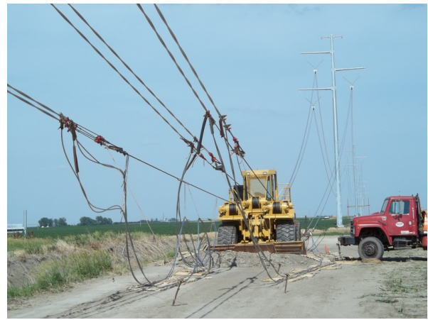
Figura 66 – Retracionamento do cabo condutor existente
