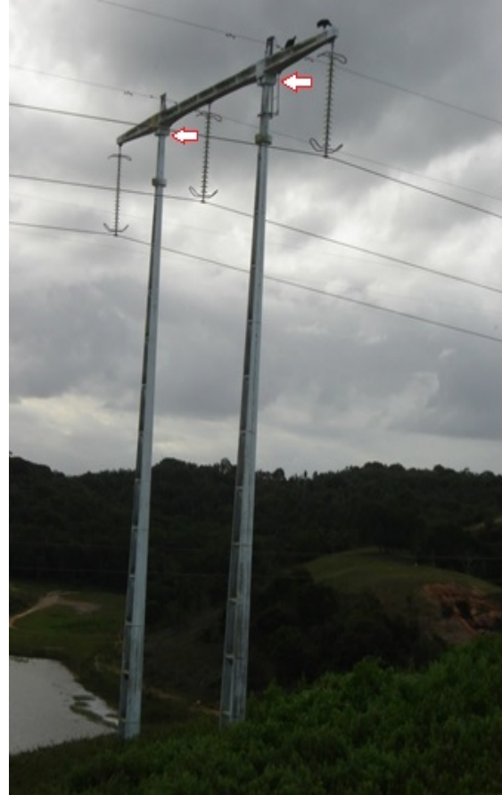
Figura 52 – Setas vermelhas indicando a inserção de anéis bipartidos
