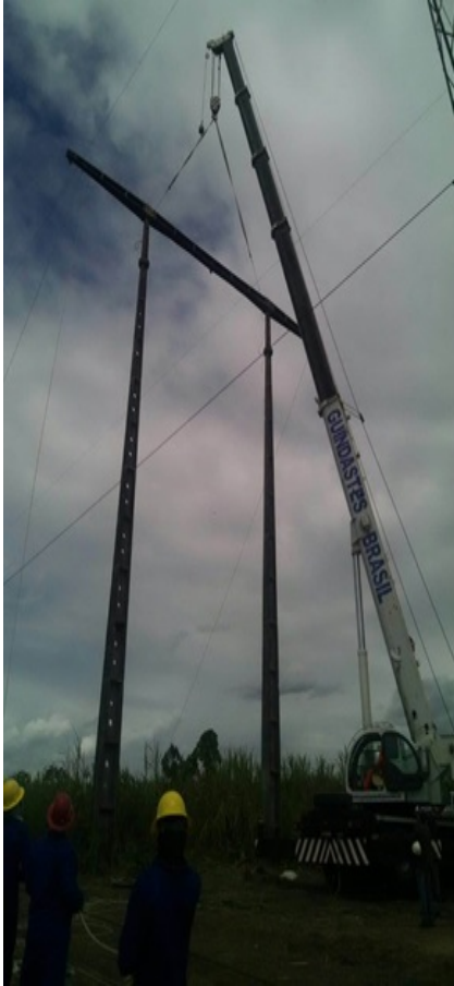
Figura 51 – Elevação da cruzeta de concreto
