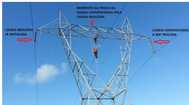
Figura 56 – Serviço de substituição de cadeias convencionais por cadeias reduzidas
