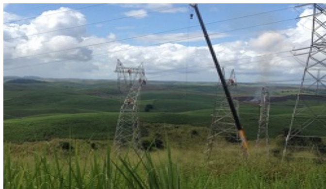
Figura 76 – Troca de estrutura
