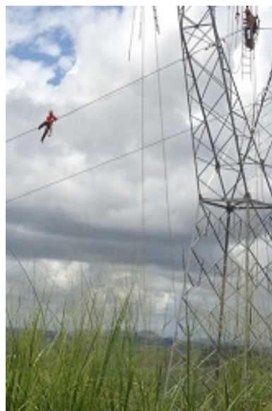
Figura 77 – Eletrícista inserindo equipamento para posterior corte do cabo condutor
