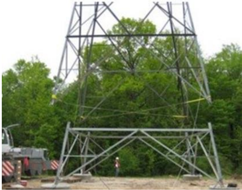
Figura 3 – Colocação da estrutura relocada em novo posicionamento em novos pés
