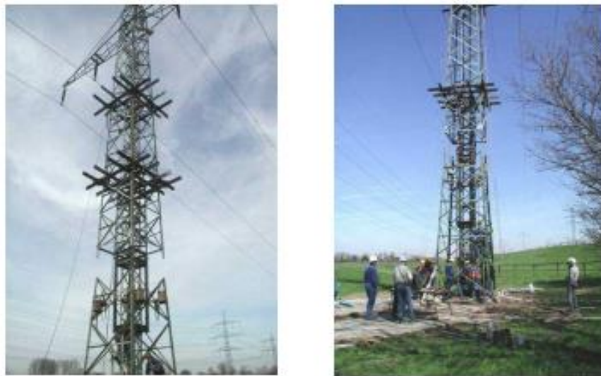
Figura 2 – Aumento de altura de estrutura metálica de suspensão
