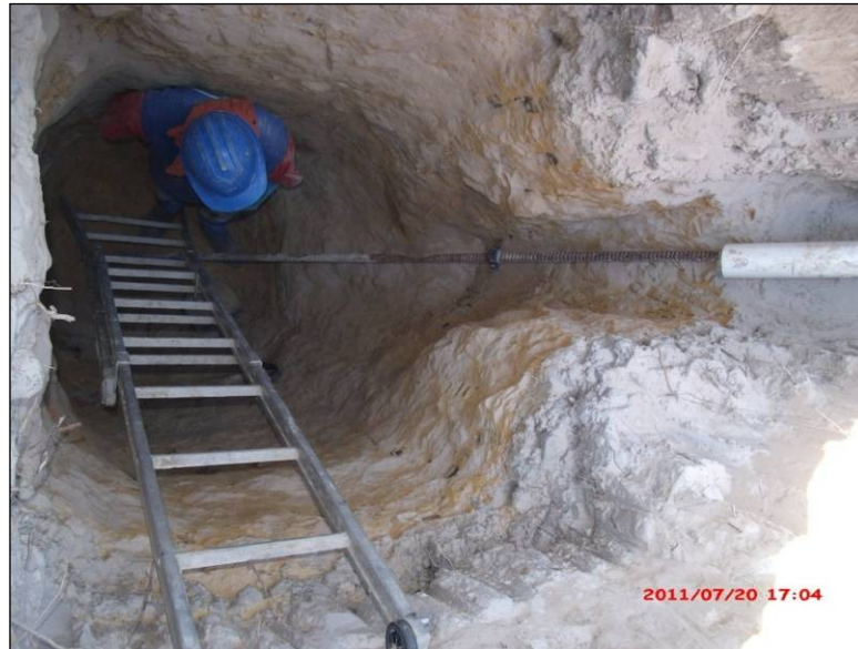
Fig. 5. Inspeção técnica visual em haste de âncora. Cortesia da STN SA.
