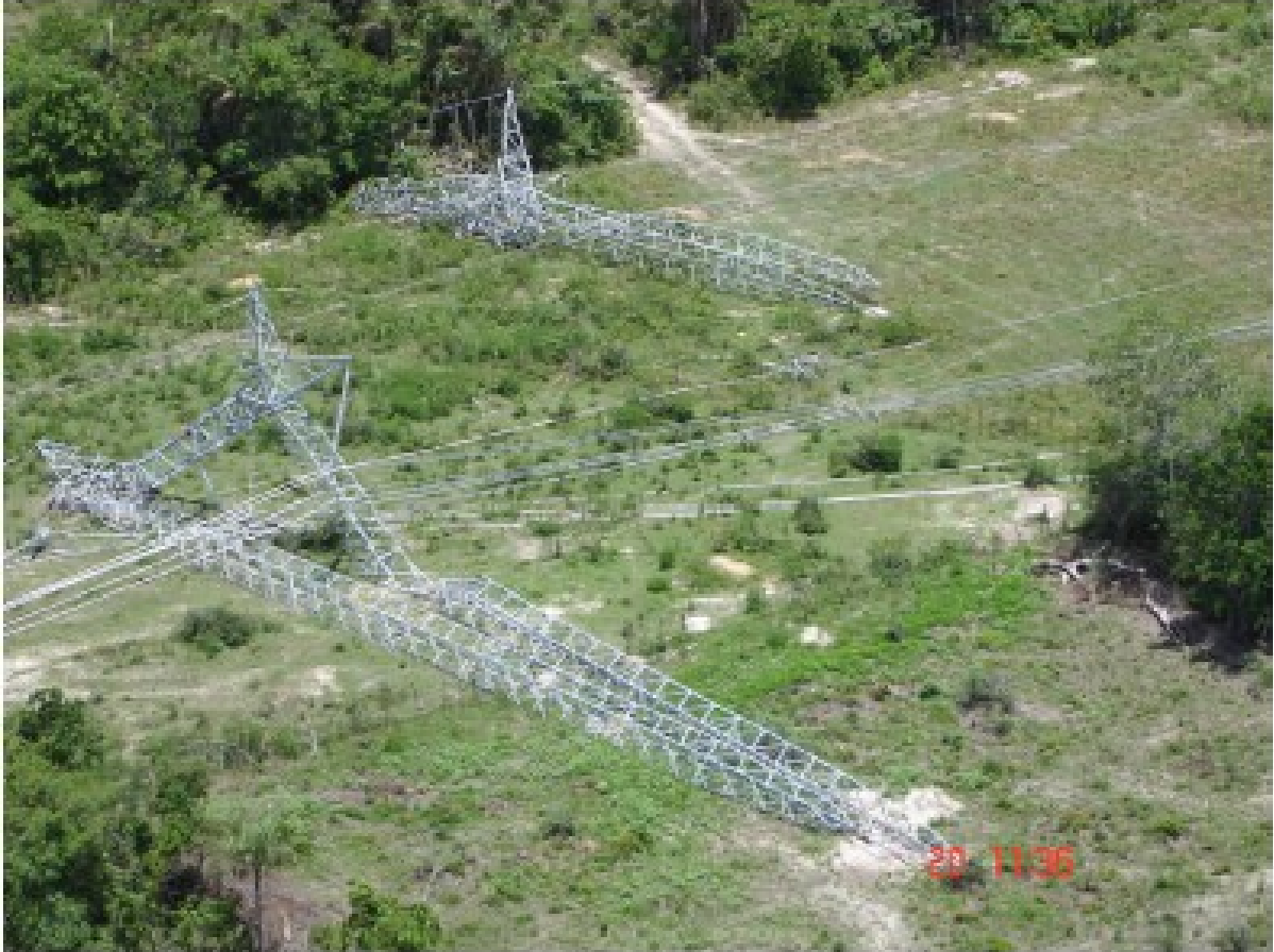
Fig. 4. Fotografia de acidente envolvendo a queda de torres estaiadas.
