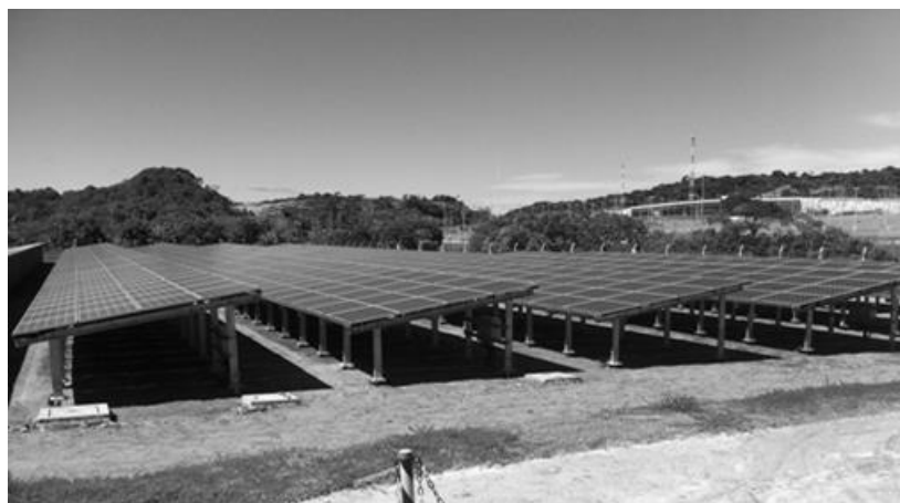
Figura 4.22 - Controle da vegetação e manutenção dos painéis da DMU-2
