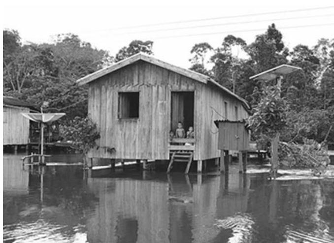
Figura 2.17 – Sistema fotovoltaico na Região Amazônica
