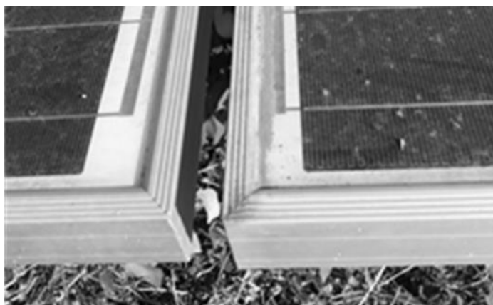
Figura 4.11 - Acúmulo de poeira na borda inferior da moldura
