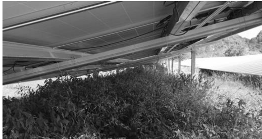
Figura 4.16 - Crescimento da vegetação sob os painéis fotovoltaicos – DMU-3
