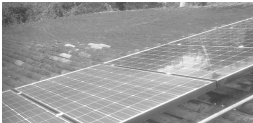
Figura 4.28 - Comparação visual entre os painéis sujos e limpos da DMU-46
