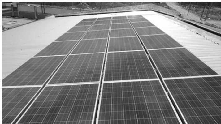
Figura 4.23 - Vista parcial dos painéis da DMU-11.
