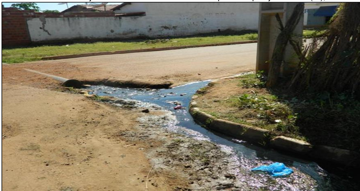
FIGURA 12 - Condição da infraestrutura no Bairro Parque de Exposição – Picos(PI), 2016.
