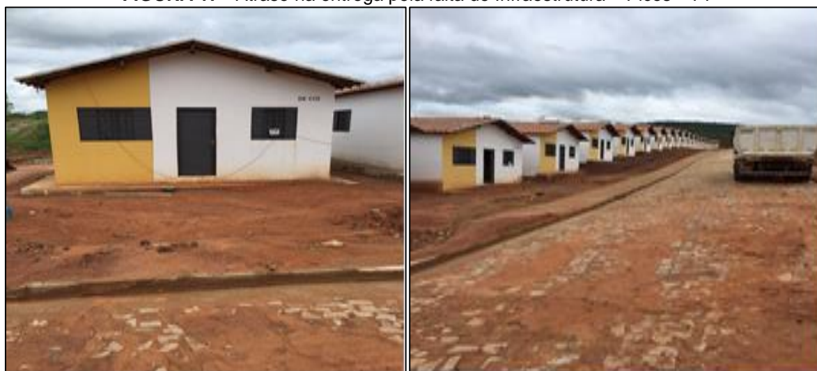
FIGURA 17 - Atraso na entrega pela falta de Infraestrutura – Picos – PI
