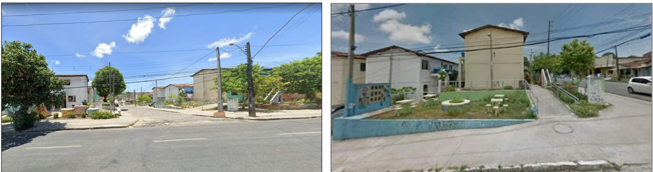
Figura 10 – Área externa dos conjuntos habitacionais Beberibe I e Solano Trindade
