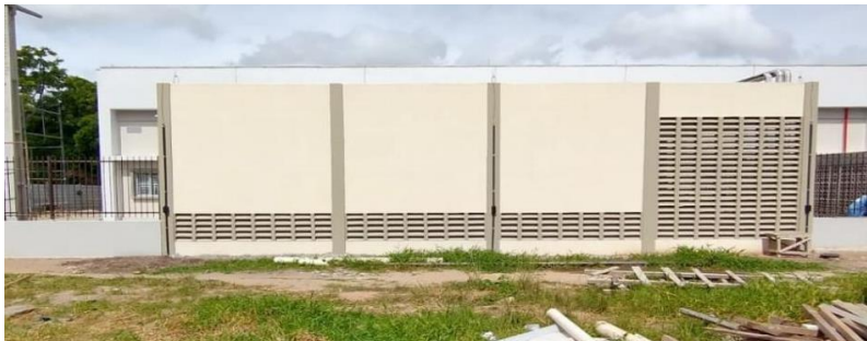
Fachada posterior da subestação
