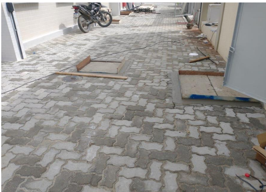
Piso intertravado da rua adjacente ao prédio.
