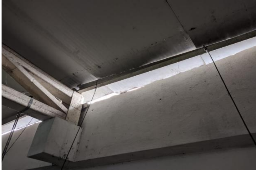
estruturas metálicas da cobertura
