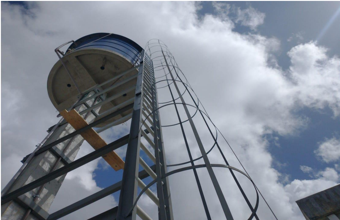
Torre pré-moldada da caixa d'água superior
