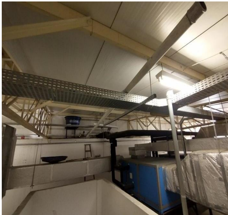
estruturas metálicas da cobertura
