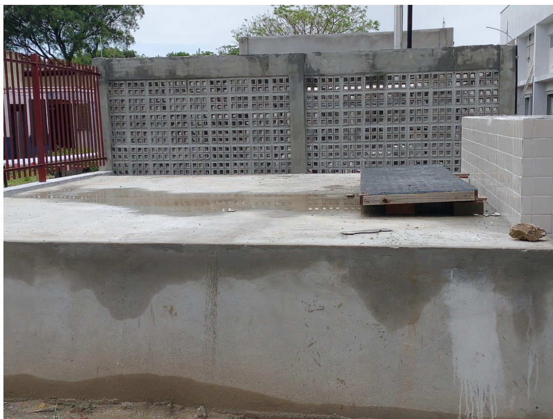
Vê-se: de frente, o reservatório d' água, ao seu lado direito a casa de bomba (cerâmica 10x10); ao seu esquerdo o gradil metálico na cor vermelha e ao fundo cobogós do schiller.
