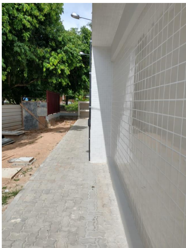
Piso intertravado da calçada na fachada Leste do prédio.
