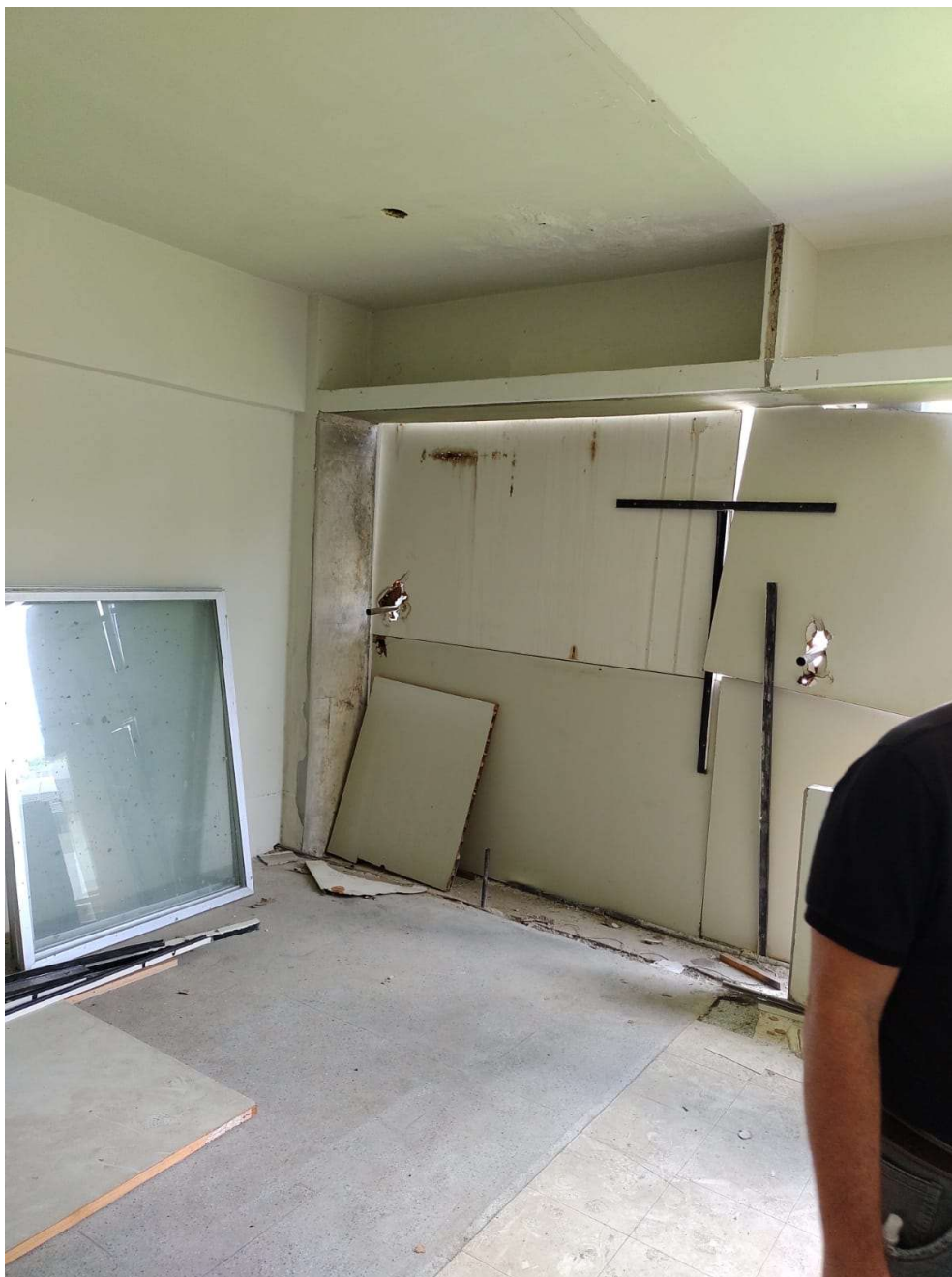
Figura 4: Trecho de viga que sofrerá corte para permitir altura de 2.10m na passagem entre os dois blocos.
