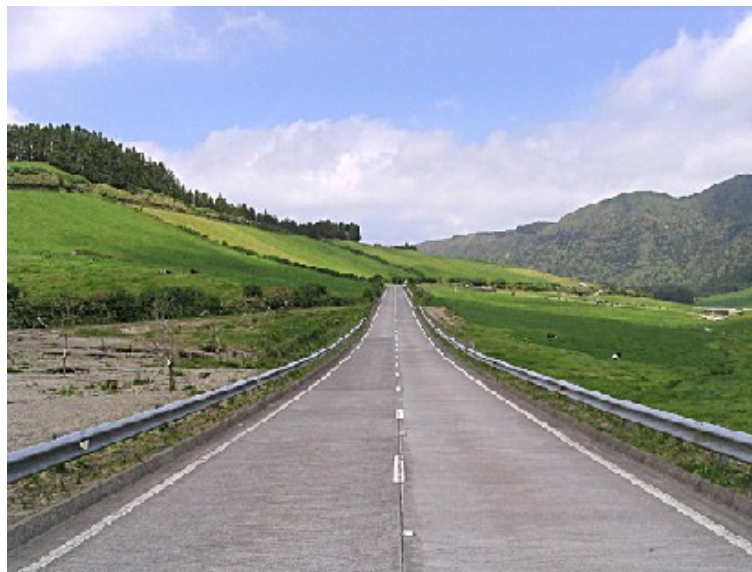
Fig. 33 a1 – Curva Vertical Côncava
