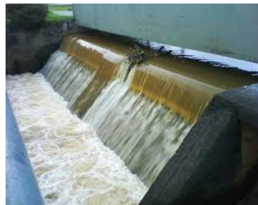
Fig.36 Vertedor com abertura retangular
