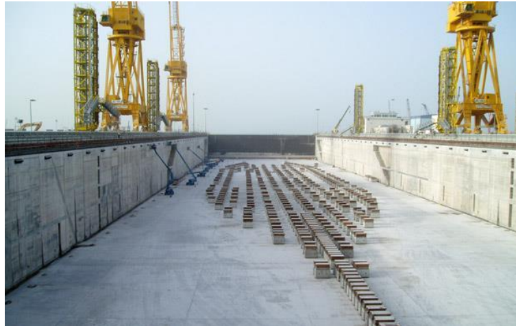
Figura 15. Exemplo de arranjo de picadeiros.
