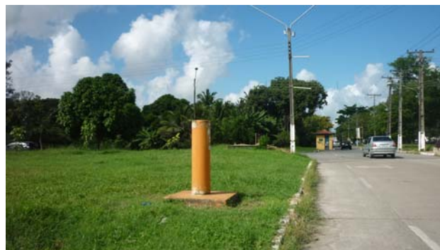
Figura 1. Estrutura dos marcos geodésicos no campus Joaquim Amazonas da UFPE, padrão RIBaC/RBMC.
